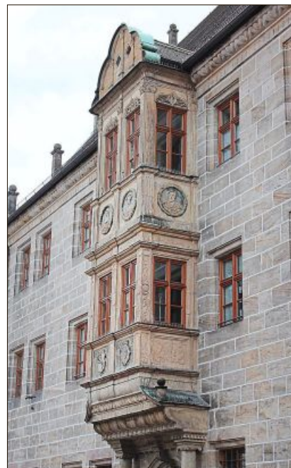
Amberg zeigte sich mit schön restaurierten Hausfassaden.
